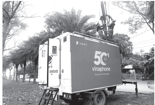
VNPT Phú Thọ triển khai lắp đặt trạm phát sóng lưu động tại khu vực Hồ Công viên Văn Lang
